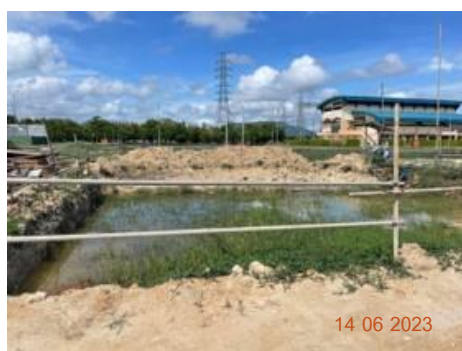
ภาพที่ 2-12 ระบบกรองทรายก่อนระบายน้ำออก นอกพื้นที่ก่อสร้าง
