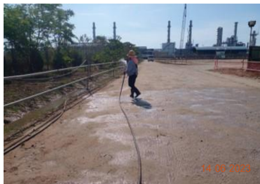
ภาพที่ 2-1 การฉีดพรมน้ำในพื้นที่ก่อสร้าง และทางเข้า-ออก พื้นที่ก่อสร้าง
