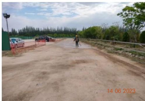
ภาพที่ 2-1 การฉีดพรมน้ำในพื้นที่ก่อสร้าง และทางเข้า-ออก พื้นที่ก่อสร้าง
